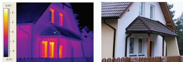
Pomocí termovize je možné vystopovat tepelné mosty - ztráty tepla
