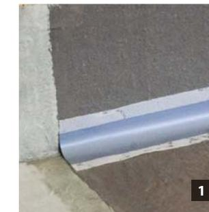
štetkou nebo válečkem po celé ploše. Kouty a rohy vyložte **Soudal Těsnícím pásem 1** který zapravte do čerstvě nanesené první vrstvy. Po zaschnutí první vrstvy aplikujte finální vrstvu stěrky. K nanášení použijte štetku, váleček nebo ocelové hladítko.
