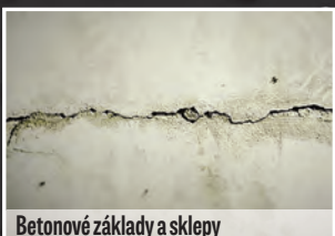
Betonové základy a sklepy
