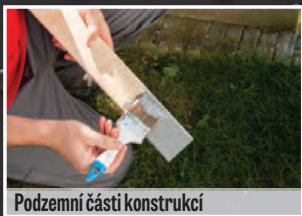
Antikorozní ochrana spojů oplechování
