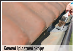
Antikorozní ochrana spojů oplechování
