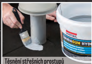
Těsnění střešních prostupů
